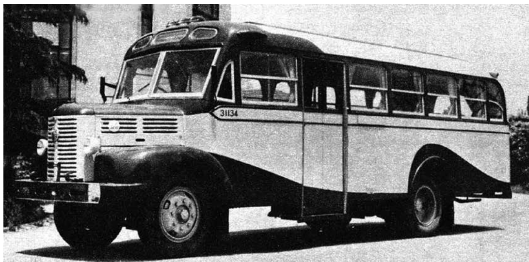
BX91 国鉄バス (1950年) 定員50名 フェンダーの形状が次期モデル(1951年型)との中間型。1949(昭和24)年7月1日、ディーゼル自動車からいすゞ自動車へ社名変更している。
