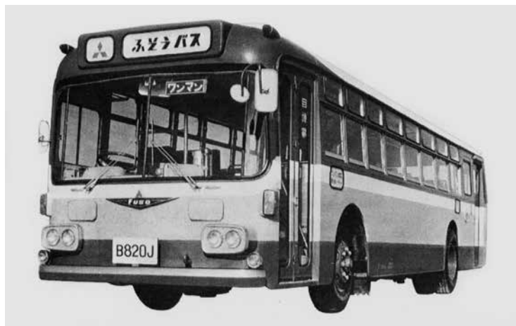
B820J 低床式ワンマンバス (1971年) L10405 W2480 H2850 WB4900 75km/h (6DB1) D-L6-8550cc 165ps 定員89名 床面地上高を標準車より300mm低くし、フロントからリアまでフラットな床構造の低床バス。
